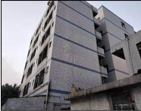
项目东北面 工业宿舍
