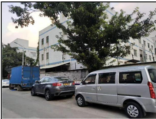
项目西南面 工业厂房
