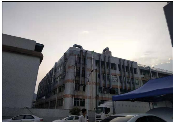
项目西北面 工业厂房
